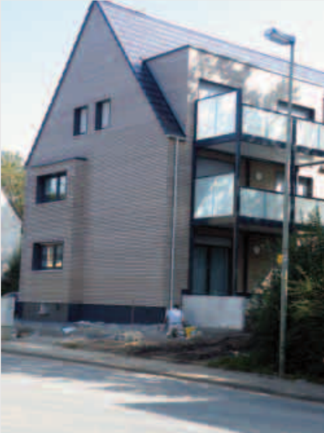
Das Passivhaus spart über 80 Prozent der Heizenergie
