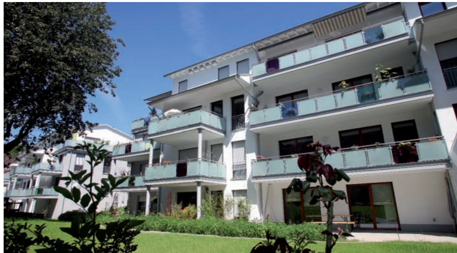
Mehrgenerationenhaus: transparente Glasplatten an den Balkonen vermitteln Offenheit. Foto: © Walter Fischer, Hattingen
